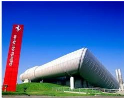
Cronologicamente è stato il primo passo del progetto. Progettata da Renzo Piano, essa si presenta con una forma simile a quella di un motore. Il suo elemento principale è un condotto tubolare di 80 metri, in cui soffia un flusso d'aria generato da una turbina ( con potenza 2200 KW).
