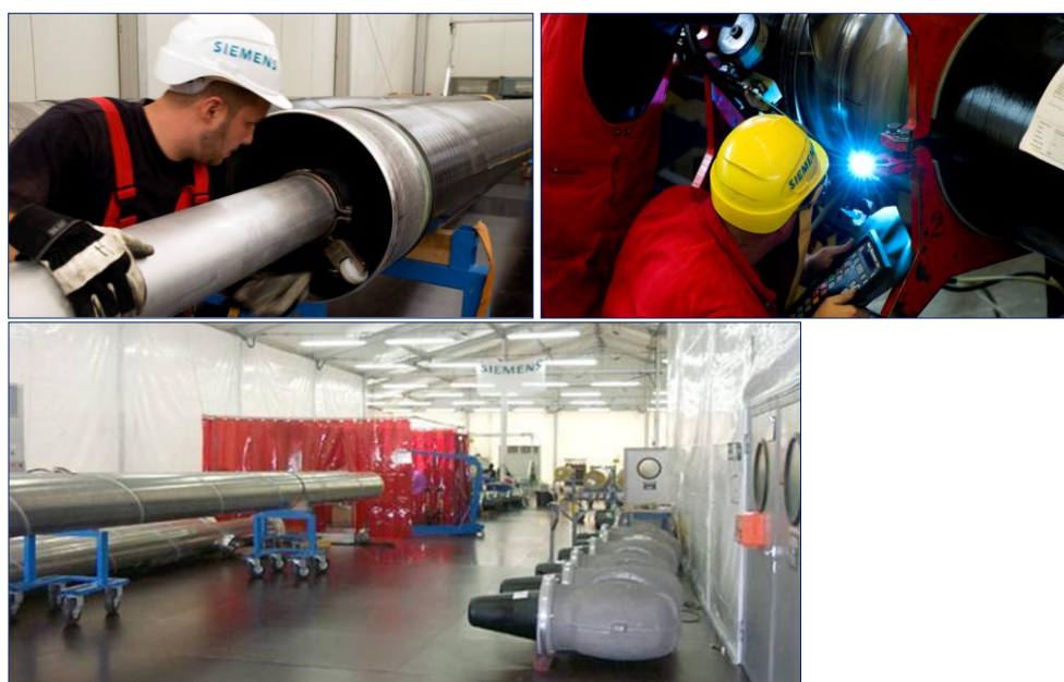
Figura 2.2 - operazioni di assemblaggio di moduli GIL
