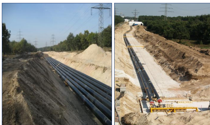
Figura 2.7 - linea GIL direttamente interrata
