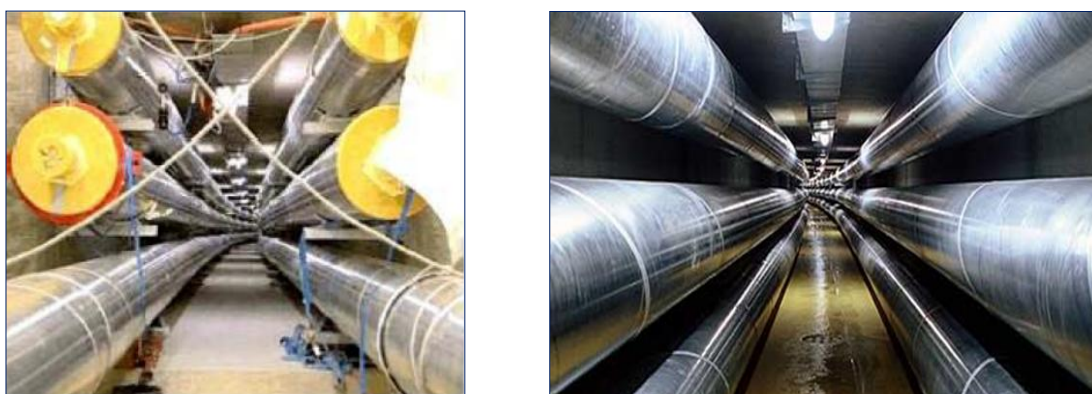
Figura 2.8 - esempi di posa in galleria di una linea GIL (durante e a posa ultimata)
