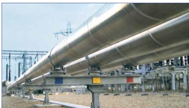
Figura 2.6 - posa in aria di una linea GIL
