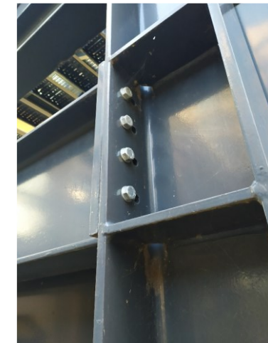
Esempi costruttivi giunto ad incastro
