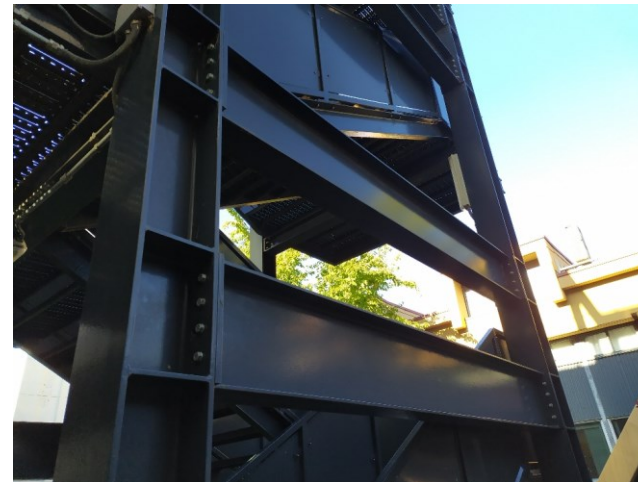
Esempi costruttivi giunto a cerniera
