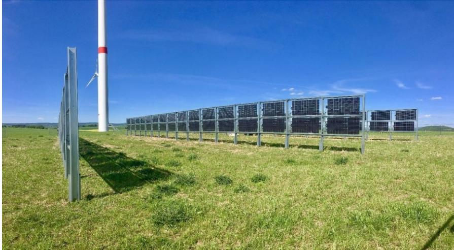
**Figura 8 - Sistema fisso a disposizione verticale dei pannelli, Germania**
