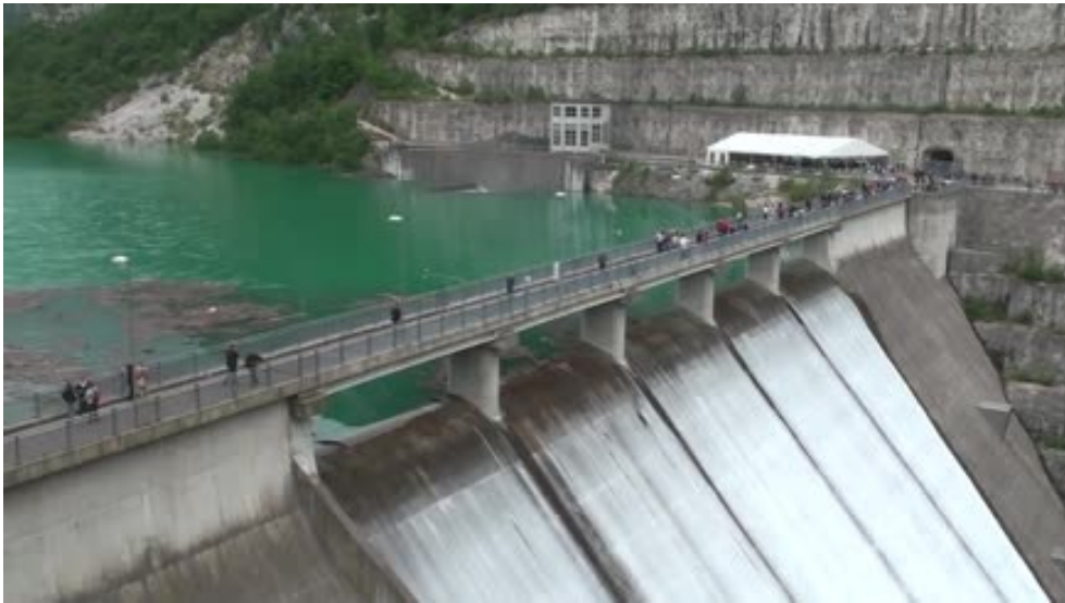
Figura 35. Soglia sfiorante del corpo della diga in funzione (fonte: www.youreporter.it ).
