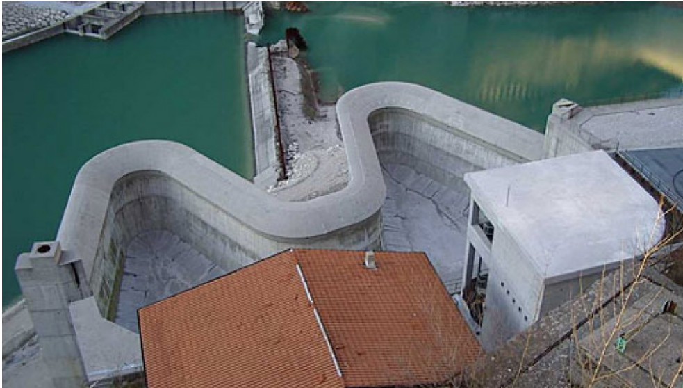
Figura 36. Sfiatore a becco d'anatra (fonte: www.progettodighe.it ).
