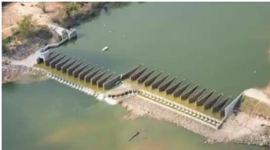
Figura 26. Esempio di sfioratore a labirinto (fonte: www.theconstructor.org ).
