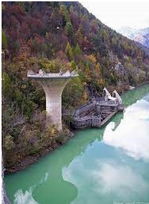
Figura 17. Esempio sfioratore a calice situato a Pontesei (Belluno) (fonte: www.progettodighe.it ).
