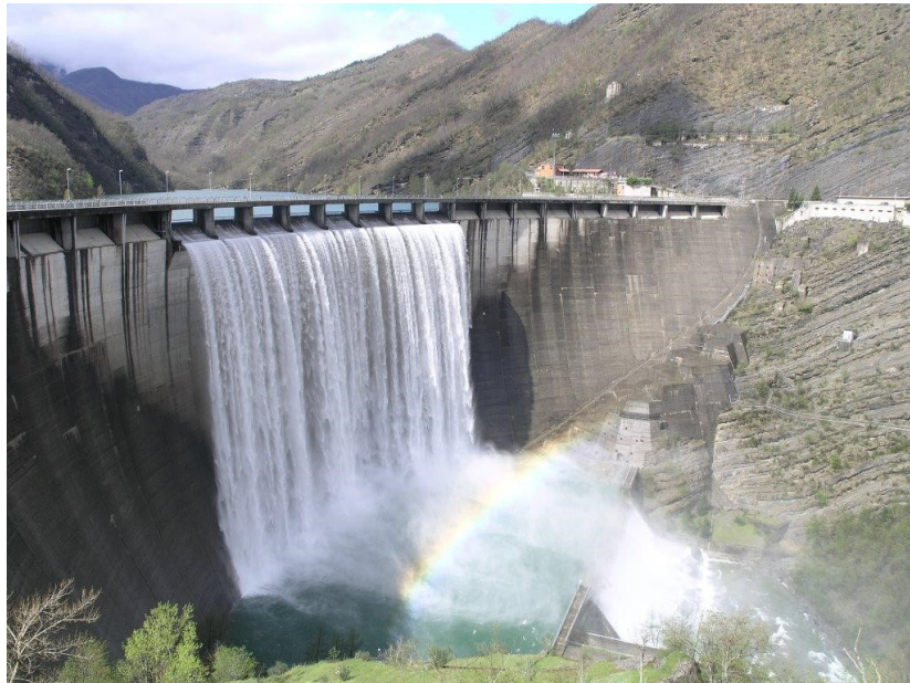
Figura 14. Esempio di scarico a caduta libera, diga di Ridracoli (Forlì) (fonte: www.dgdighe.mit.gov.it ).
