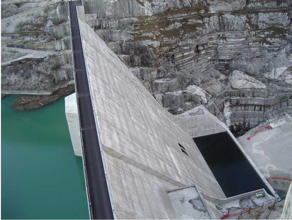
Figura 34. Vista dall'alto corpo diga e bacino di calma (fonte: www.progettodighe.it ).
