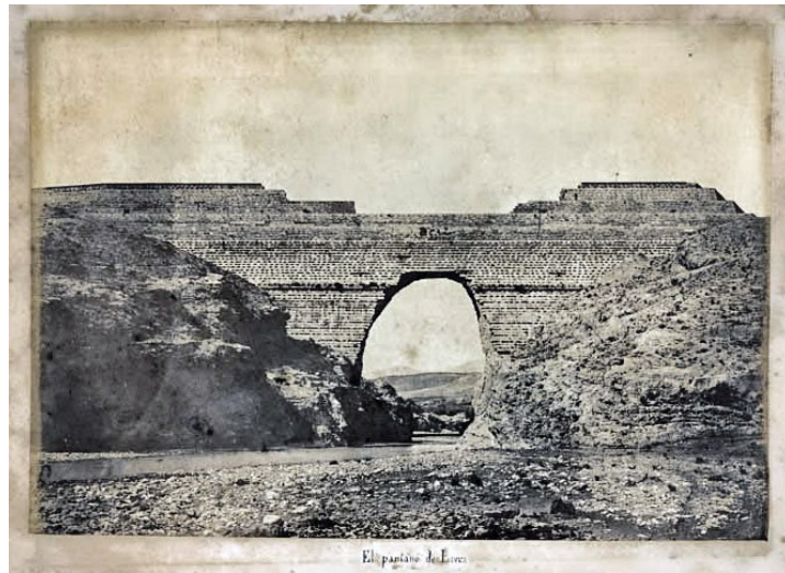
Figura 1. Resti della seconda diga, la parte centrale mancante è stata trascinata via a causa del sifonamento del terreno (fonte: www.dgdighe.mit.gov.it ).
