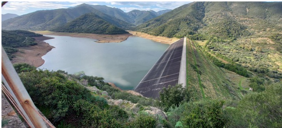
Figura 6. Esempio di diga formata da materiali sciolti a Villacidro (Sud Sardegna) (fonte: www.enas.sardegna.it ).
