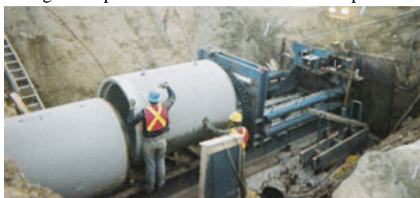
Figura 1.16 Esempio di posa pipe jacking
