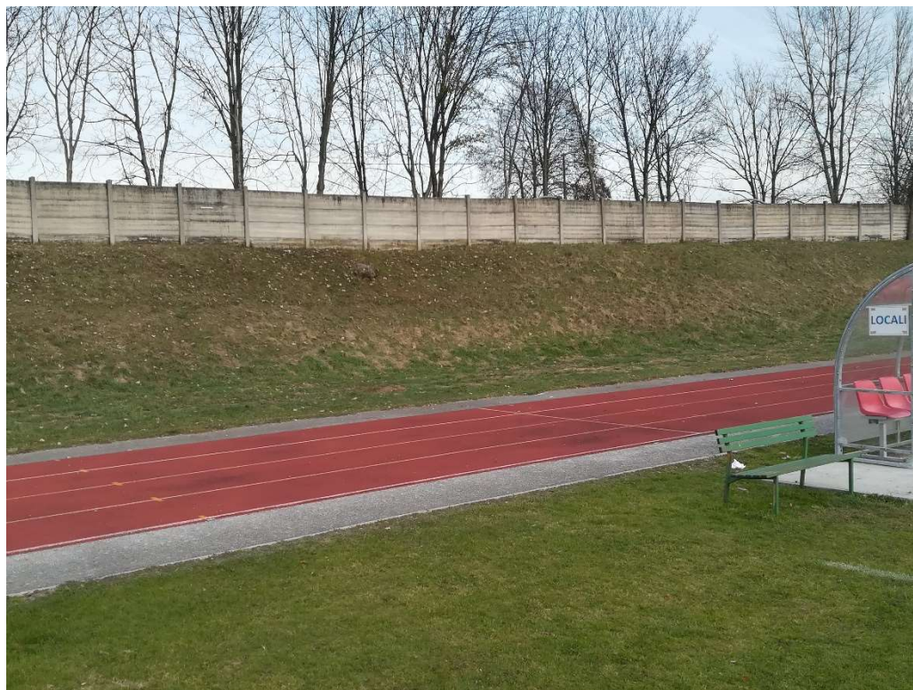
Figura 4.50. Foto che mostra nel dettaglio il terrapieno con il muro perimetrale dell’impianto sportivo di Santa Giustina
