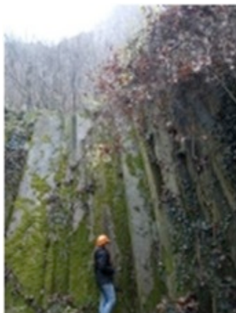
Foto 2. Fessurazione colonnare di Monte Cinto
