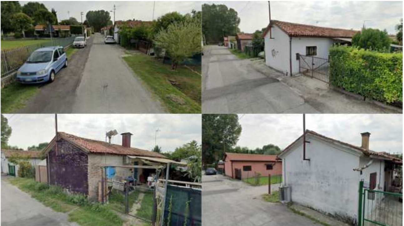
Figura 2.3 – Foto rilievo dello stato di fatto. [Fonte: elaborazione dell'autore]
