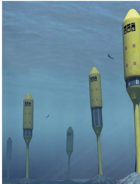
Figura 3.11: Immagine di un impianto con *Archimedes Wave Swing*
