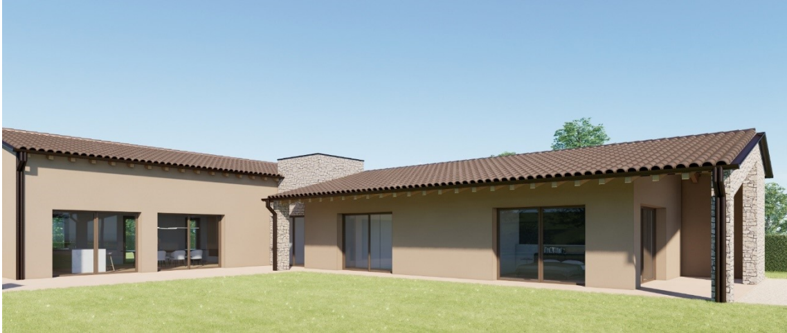
Figura 4-2 Vista Ovest abitazione
