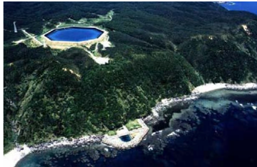
Figura 3.4: Impianto di pompaggio nell'isola di Okinawa, Giappone
