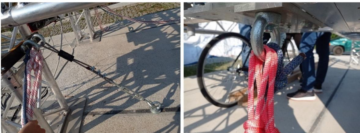
*Figura 0-19Punti di fissaggio corde d'arresto*
