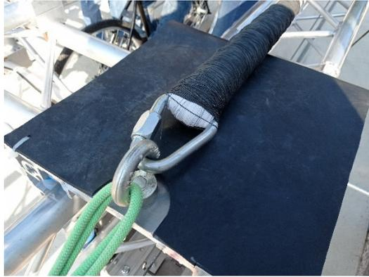
Figura 0-11 Moschettone fissaggio elastico
