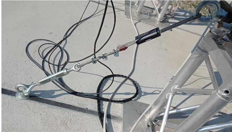
*Figura 0-5 Controventi struttura*
