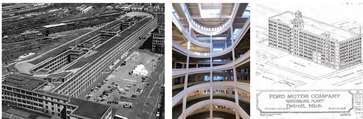
Figura 16: A sinistra e al centro immagine aerea e vista interna della rampa elicoidale dello stabilimento FIAT 'Lingotto' realizzato nel 1924 su progetto dell'ingegnere torinese Giacomo Mattè-Trucco, a destra un disegno della Ford Motor Company di Albert Kahn.
