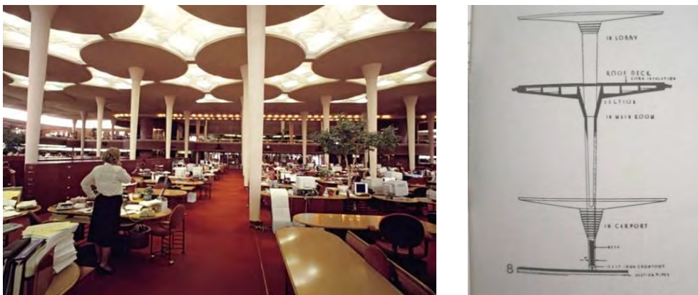
Figura 6: A sinistra vista della zona uffici, a destra schema strutturale dei pilastri a fungo sovrapposti.
