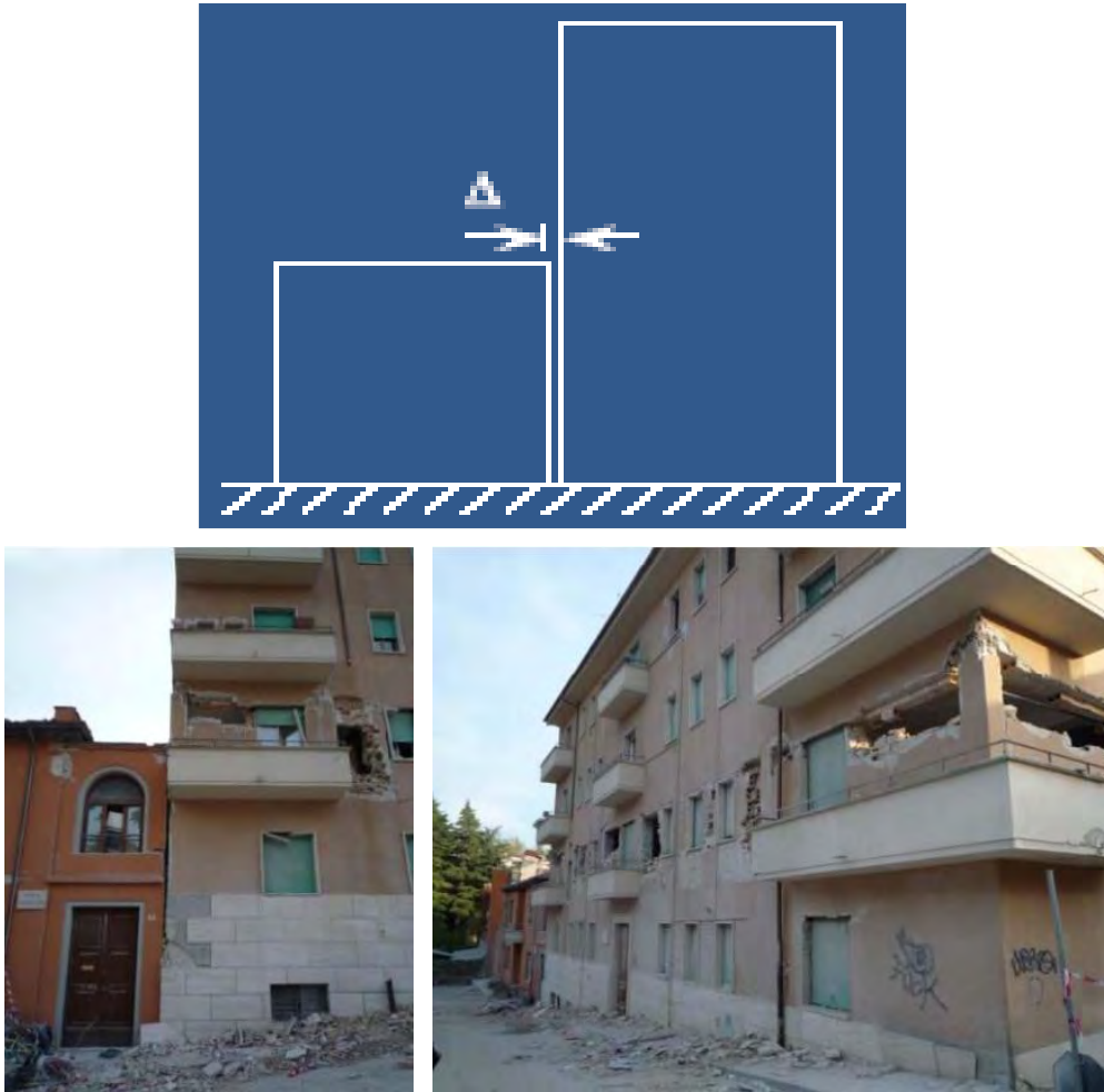
Figura 2.4-3 Schema di edificio irregolare in altezza ed effetto di martellamento (L'Aquila 2009)(fonte Lezioni di Costruzioni in Zona Sismica)
