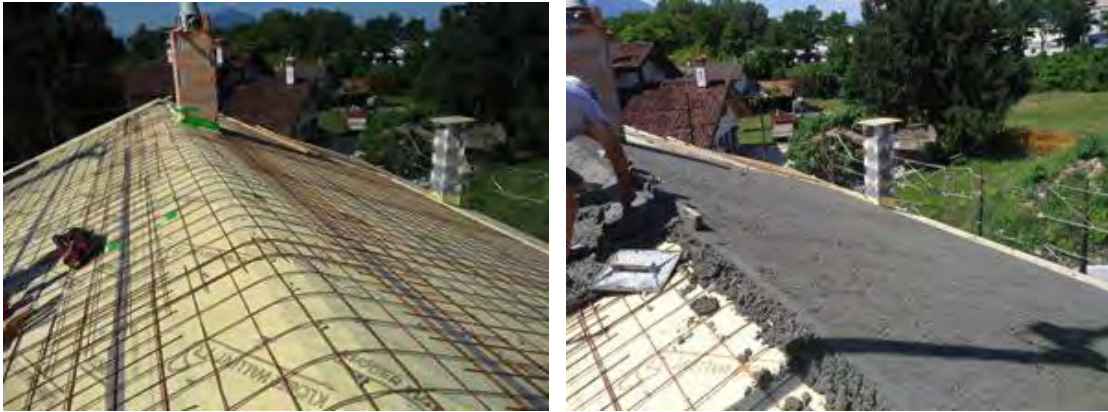
Figura 3.3-2 Realizzazione copertura (fonte Canal e Mosele, 2013)
