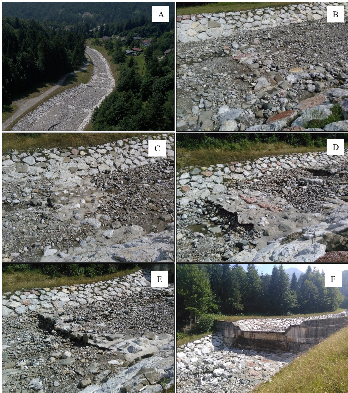
Fig. 28 A) Briglia Agozza_8 e soglie Agozza_7-6-5; B) Soglia Agozza_4; C) Soglia Agozza_5; D) Soglia Agozza_6; E) Soglia Agozza-7; F) Briglia Agozza_8.
