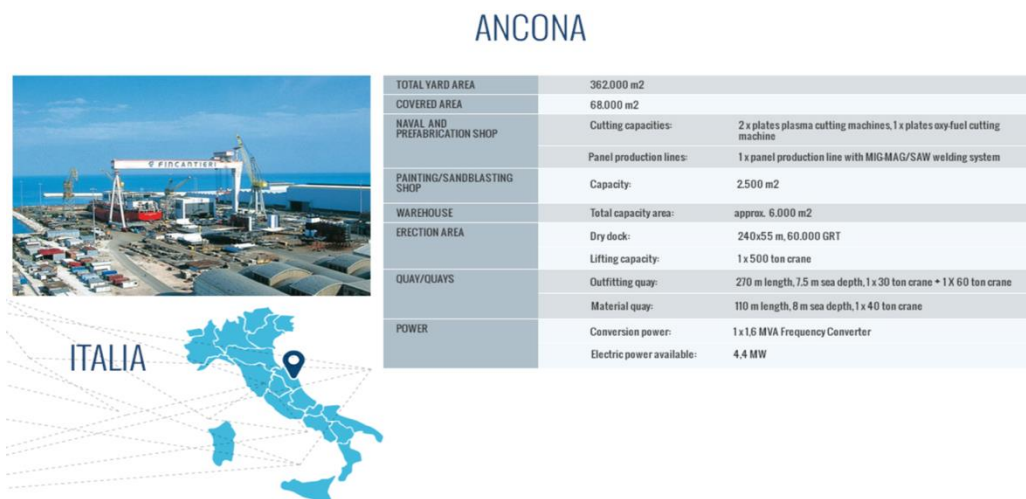
Fig. 5.12 Il cantiere di Ancona (Fincantieri S.p.A., s.d.).
