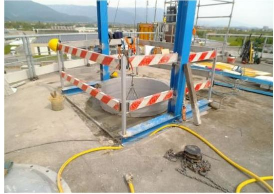
Figura 37 - Installazione cavalletta a protezione del foro in copertura
