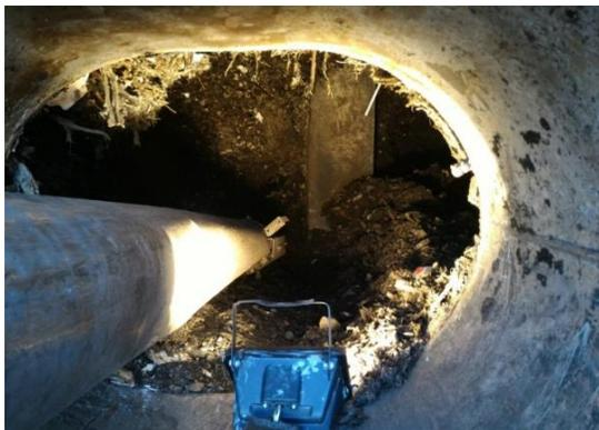
Figura 41 - Svuotamento del reattore
