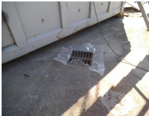
*Figura 34 - Isolamento dei sottoservizi con teli in nylon*
