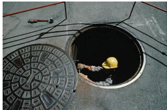
Figura 24 - Esempio di accesso ai condotti della fognatura
