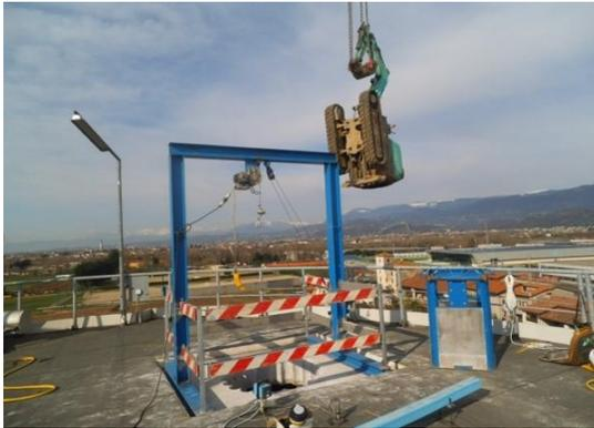
Figura 38 - Inserimento mini escavatore all'interno del reattore
