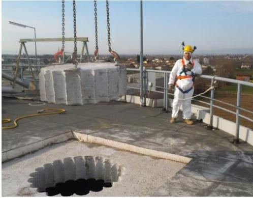
Figura 36 - Carotaggio per la creazione del foro in copertura
