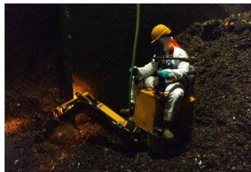
Figura 26 - Esempio di lavoro all'interno di un digestore
