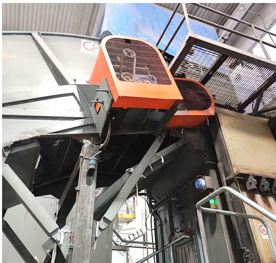
Figura 10 – dettagli interfaccia tra macchinari.
