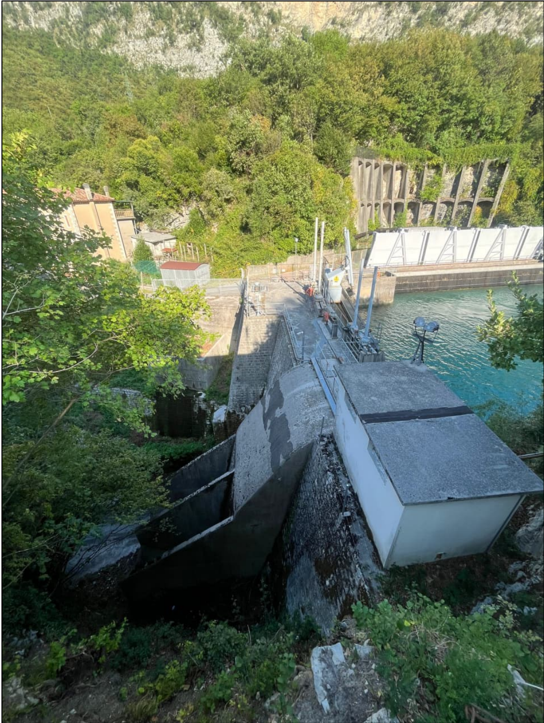
Figura 5.1: Opera di sbarramento e presa sul Lago del Restrello. Tratta da: https://progettodighe.it/centrali/san-floriano-vittorio-veneto-tv/
