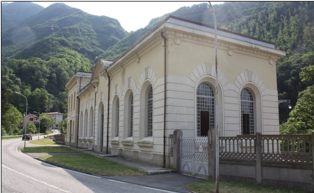
Figura 5.9: Vista prospetto est, centrale di San Floriano (1919).
