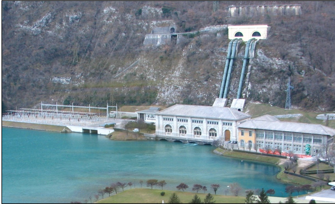
Figura 4.12: La centrale idroelettrica di Nove Nuova (1971); vista esterna. Fonte: https://progettodighe.it/centrali/
