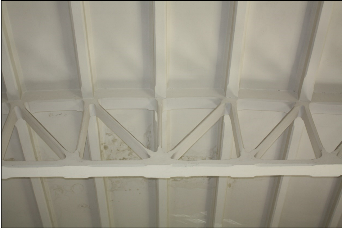
Figura 5.15: Particolare della capriata in calcestruzzo armato, centrale di San Floriano (1919).
