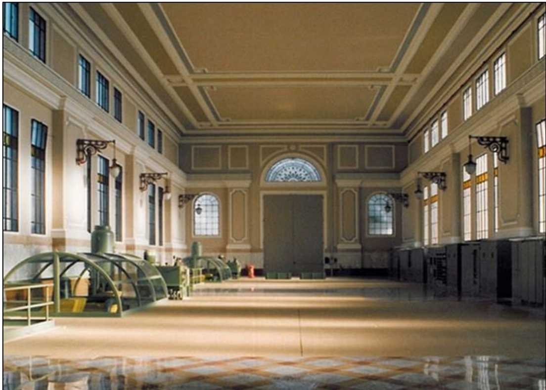
Figura 4.8: La centrale idroelettrica di Caneva (1927); vista interna sala macchine. Fonte: https://www.ilfriuli.it/viaggi/il-fai-giovani-alla-scoperta-della-centrale-idroelettrica-di-caneva/
