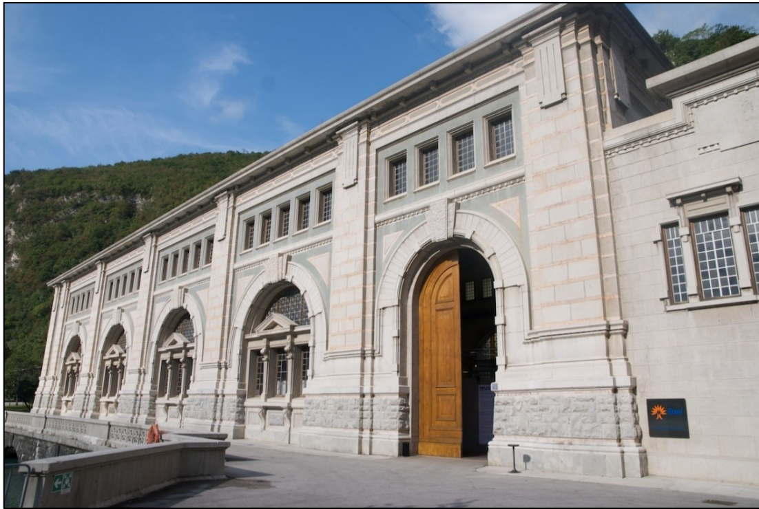
Figura 4.6: La centrale idroelettrica di Nove (1925); vista esterna sala macchine. Fonte: https://progettodighe.it/centrali/
