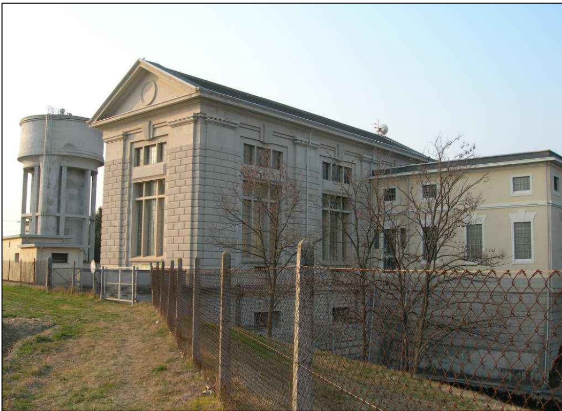
Figura 4.9: La centrale idroelettrica di Cavolano (1930); vista esterna sala macchine. Fonte: https://progettodighe.it/centrali/
