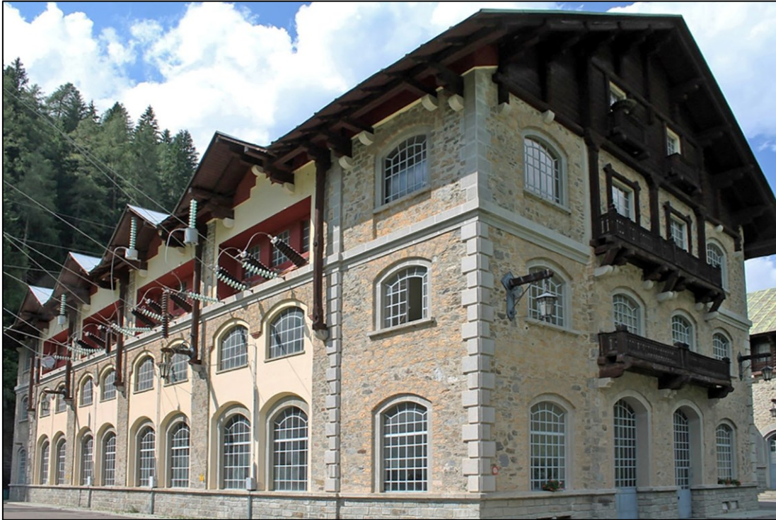
Figura 2.12: Centrale di Cogolo (1929); vista esterna.
