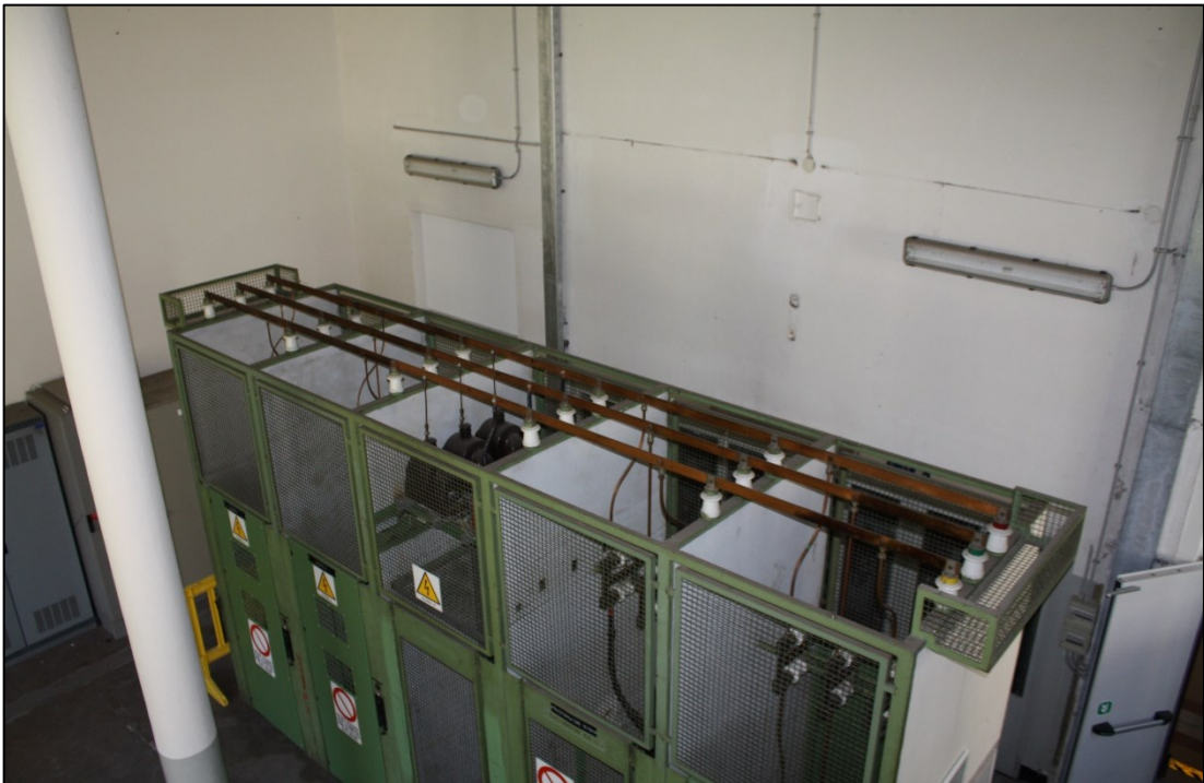
Figura 5.16: Vista interna, “sala comandi”, centrale di San Floriano (1919).
