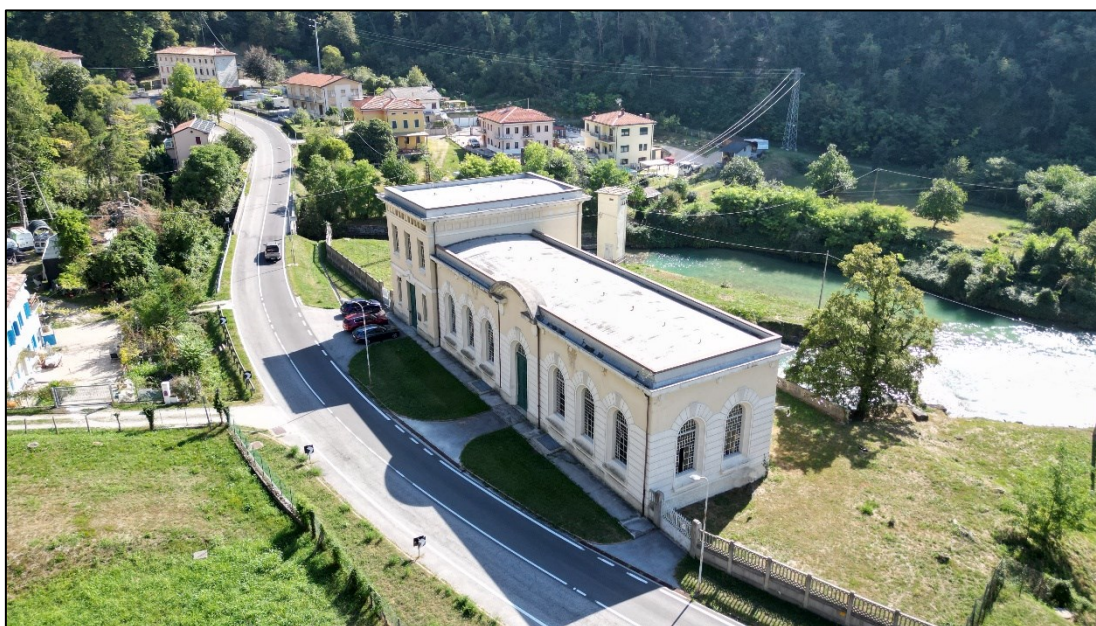
Figura 5.5: Vista generale, centrale di San Floriano (1919).
