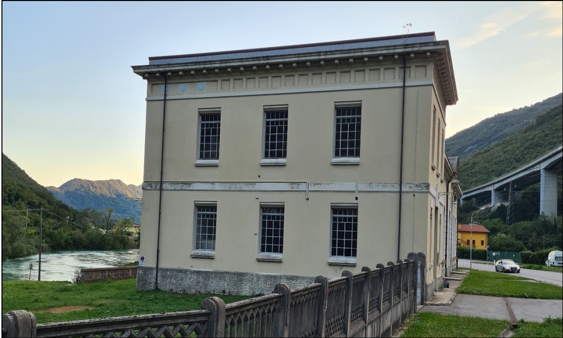
Figura 5.10: Vista prospetto ovest, centrale di San Floriano (1919).
