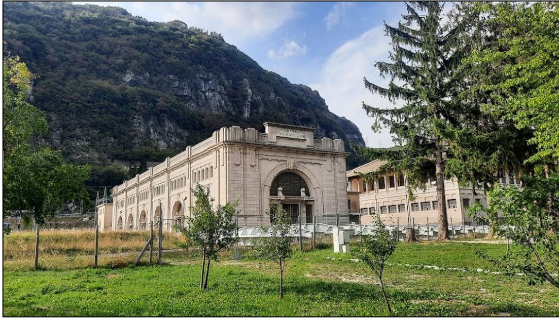
Figura 4.3: La centrale idroelettrica di Fadalto (1923); vista esterna sala macchine. Fonte: https://progettodighe.it/centrali/
