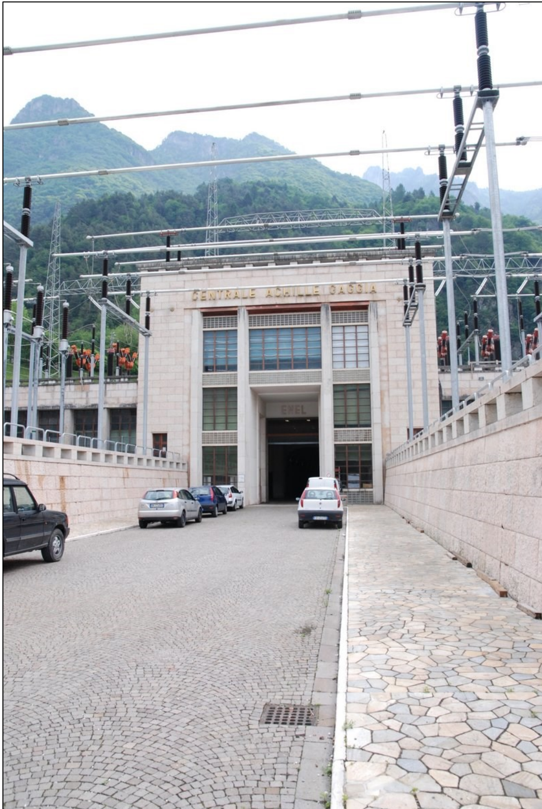
Figura 2.7: Centrale in caverna "Achille Gaggia" a Soverzene (BL); vista facciata esterna. Fonte: https://progettodighe.it/centrali/achille-gaggia-soverzene-bl/
