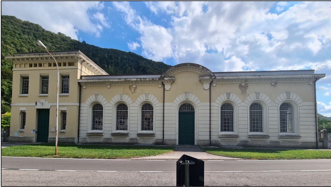
Figura 5.6: Vista prospetto principale nord, centrale di San Floriano (1919).
