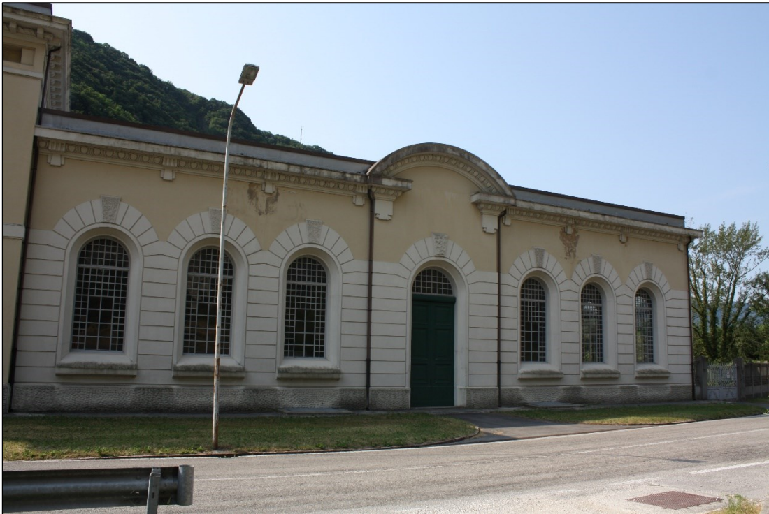
Figura 5.7: Vista prospetto principale nord, “sala macchine”, centrale di San Floriano (1919).
