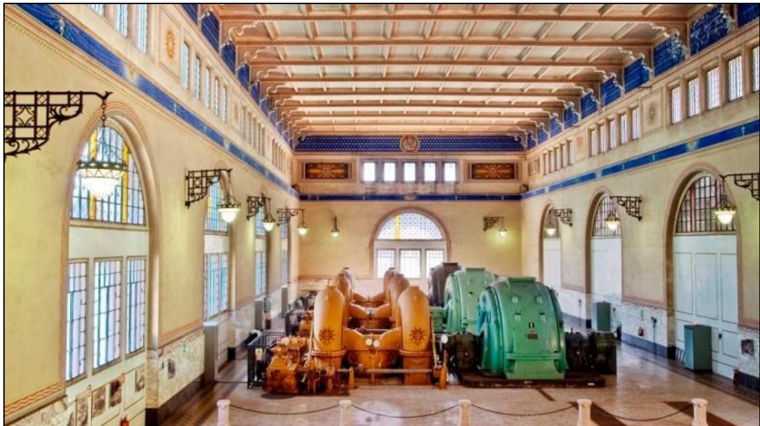
Figura 2.9: Centrale all'esterno di Nove (1925); vista interna, sala macchine. Fonte: https://tribunatreviso.gelocal.it/treviso/cronaca/2016/11/25/news/alla-centrale-di-nove-la-mostra-sulla-grande-guerra-1.14467527
