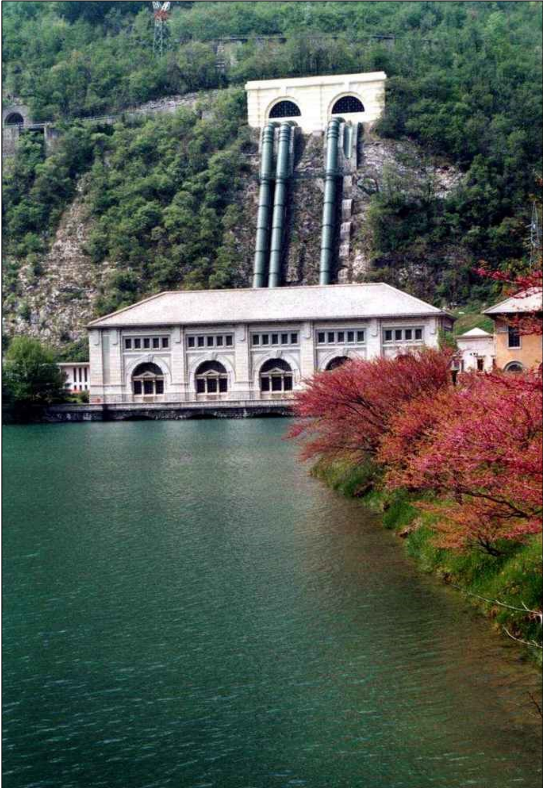
Figura 2.10: Centrale all'esterno di Nove (1925); vista esterna. Fonte: https://progettodighe.it/centrali/nove-1925-nove-tv/
