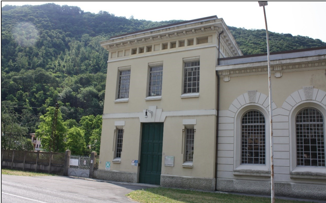
Figura 5.8: Vista prospetto principale nord, “sala comandi”, centrale di San Floriano (1919).
