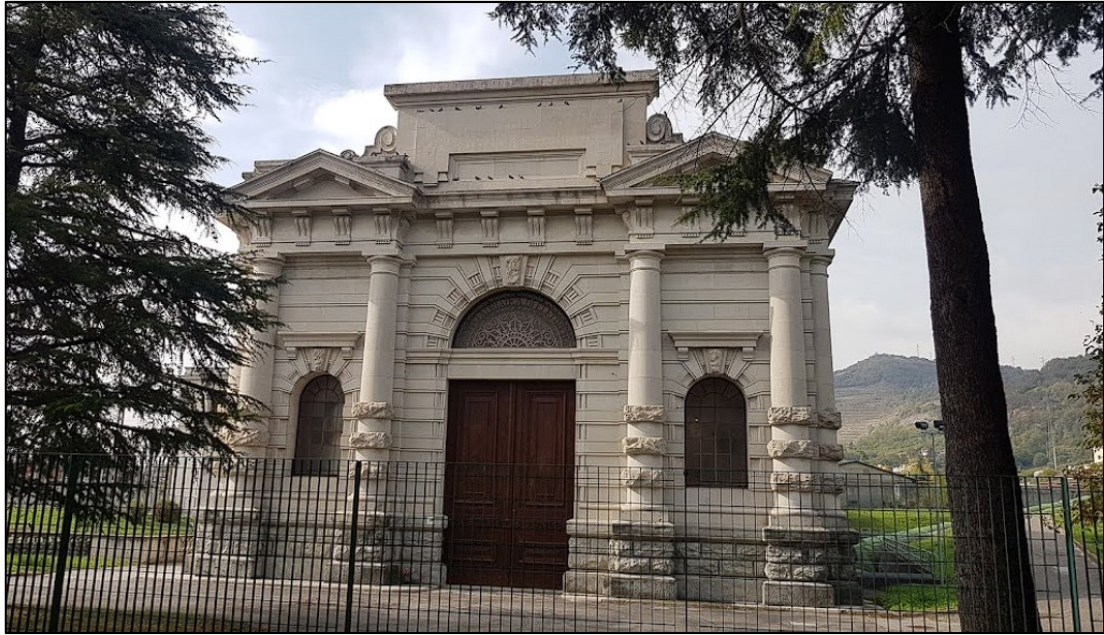
Figura 4.7: La centrale idroelettrica di Caneva (1927); vista esterna sala macchine. Fonte: https://progettodighe.it/centrali/
