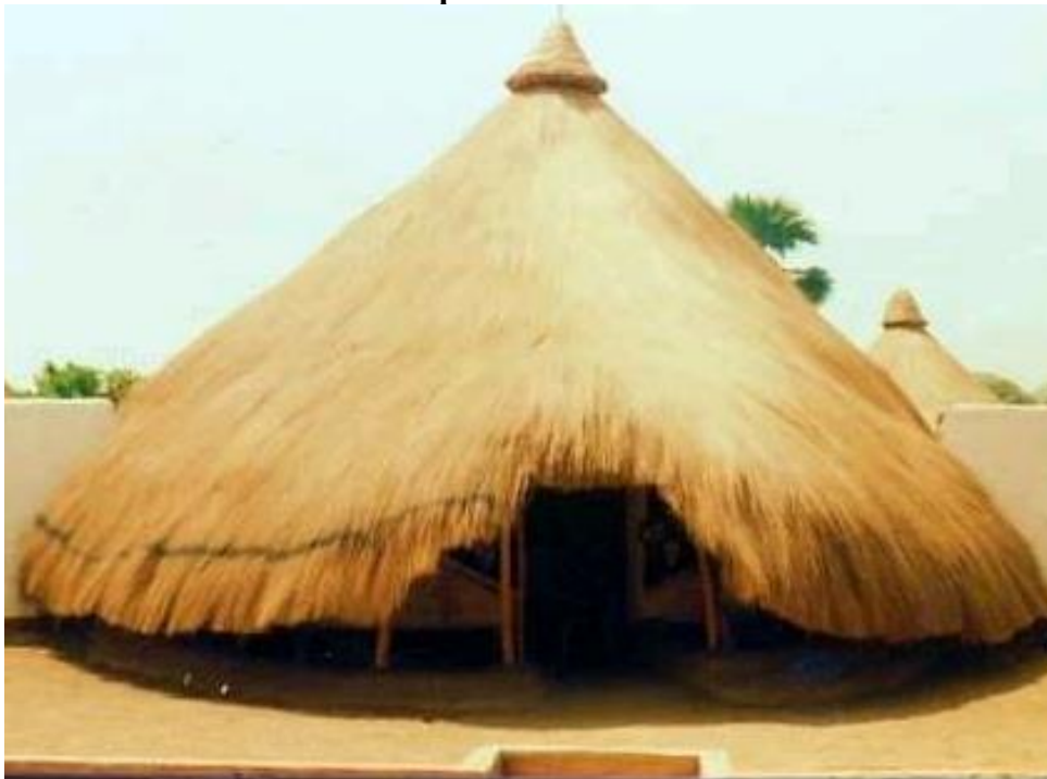
Photo 7 : Entrée de la chefferie Mboum recouvert d'un toit conique stylisé de paille traitée
