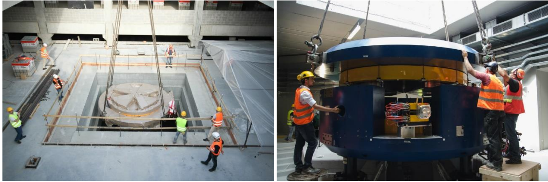
Figura 2.8: Il ciclotrone nelle fasi di installazione nel nuovo edificio SPES [6].
