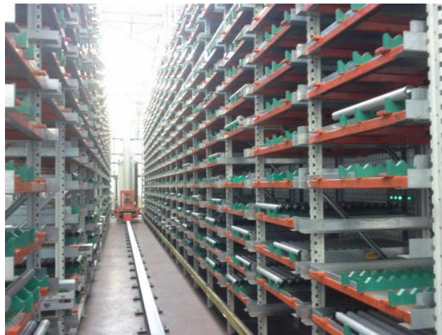
(b) Vista interna.
