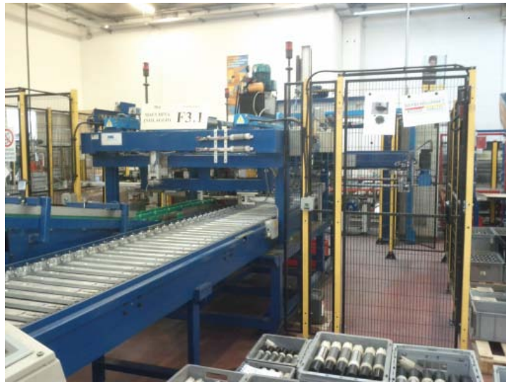
Figura 2.3: Macchina automatizzata per l'operazione di infilaggio del motore
