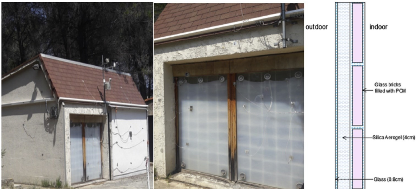
Figura 5.2.1.1 - Parete TIM-PCM dall'esterno e relativo schema di composizione della parete. [34]
