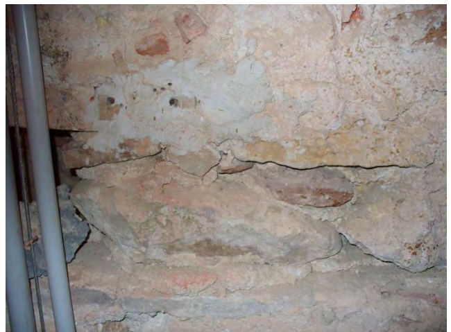
Paramento murario livello 3
