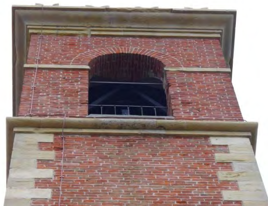
Cella campanaria, lato Sud
