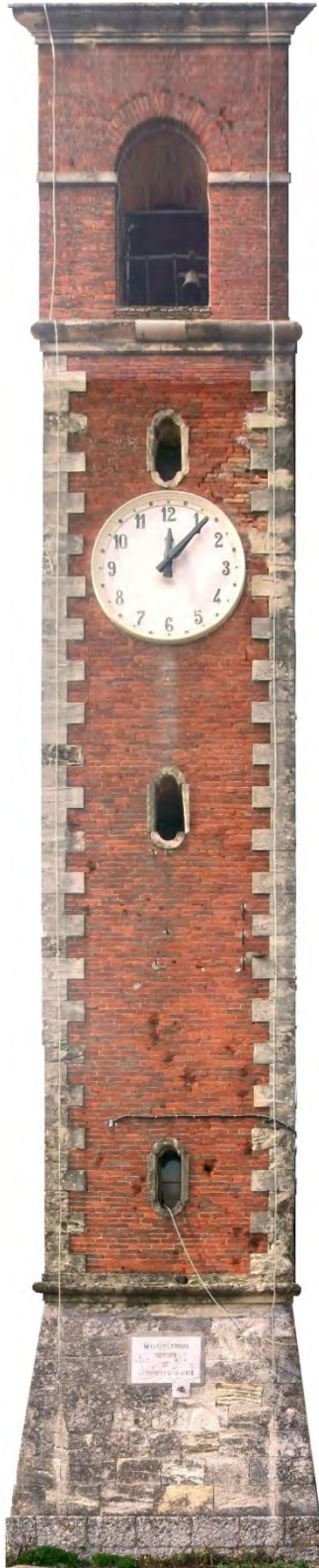
2.11 Prospetto Est antecedente al restauro 2013
