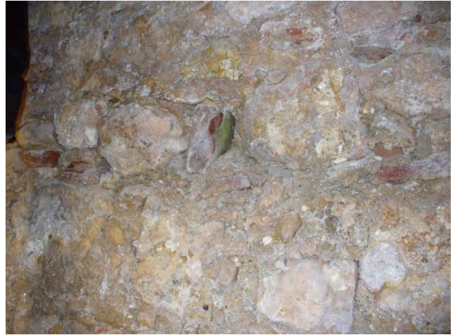
Paramento murario livello 2
