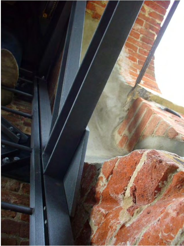
Scavo piedritti cella preesistenti
