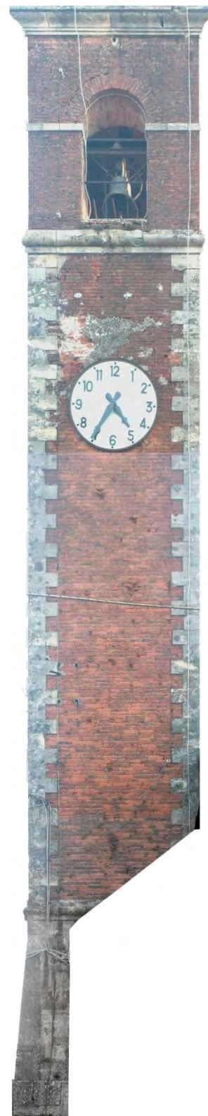
2.12 Prospetto Nord antecedente al restauro 2013
