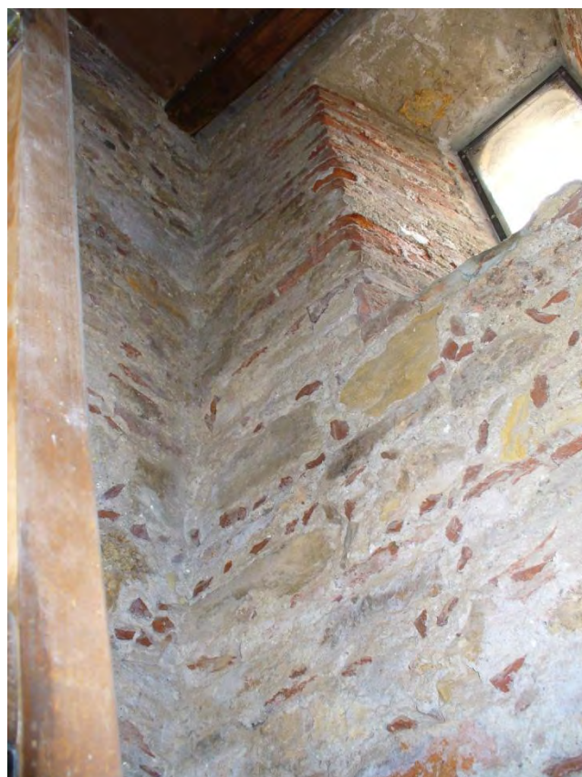
Paramenti murari livello 0
