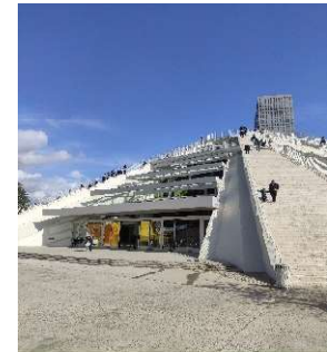
L'edificio dopo la ristrutturazione
