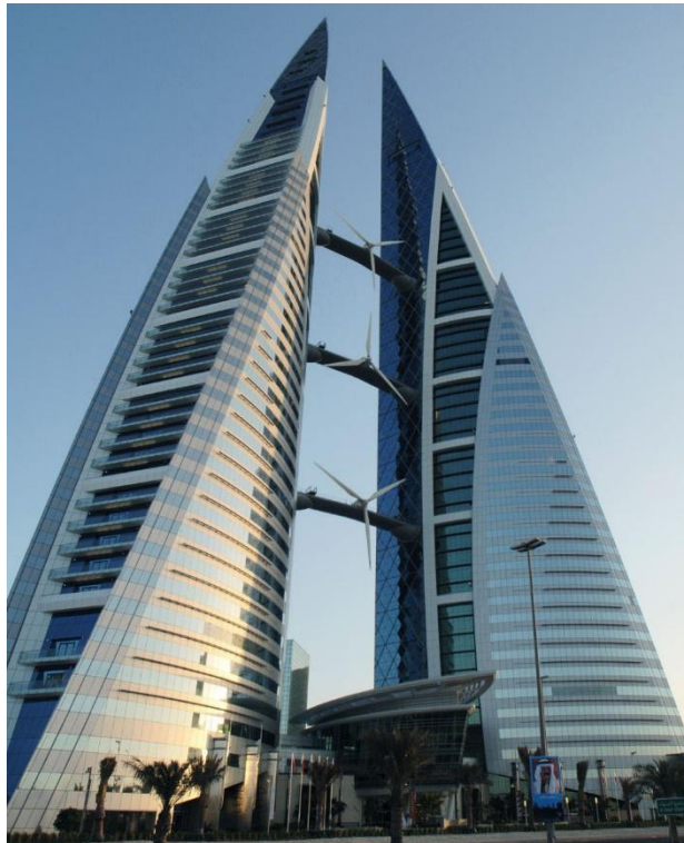
Figura 2 – Integrazione di turbine eoliche sull'edificio Bahrain World Trade Center
