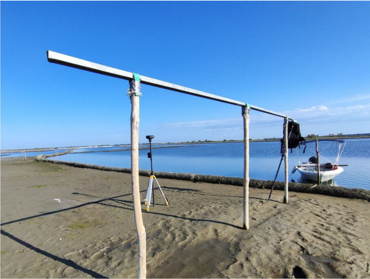
Fig. 1.2.8 - Burghe ripristinate con geogriglie di polimeri riempite di pietrame.
