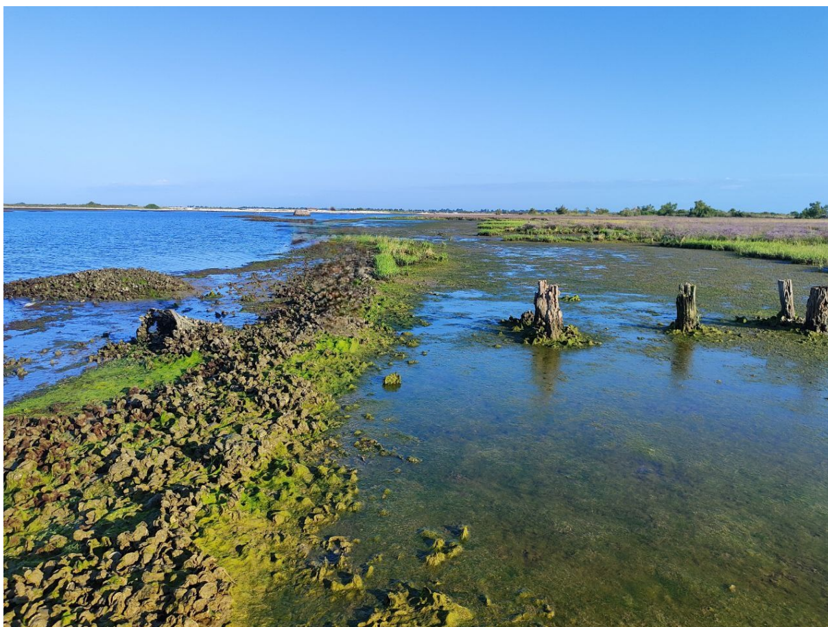
Fig. 1.2.7 - Burghe preesistenti degradate.
