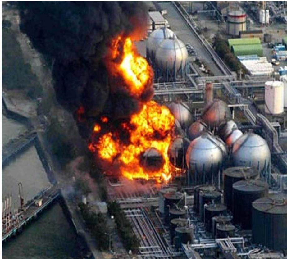
Fig. 4.1: Fotografia di un incendio in un Parco serbatoi – Raffineria di Chiba della Cosmo Oil, Terremoto di Sendai 11 marzo 2011.
