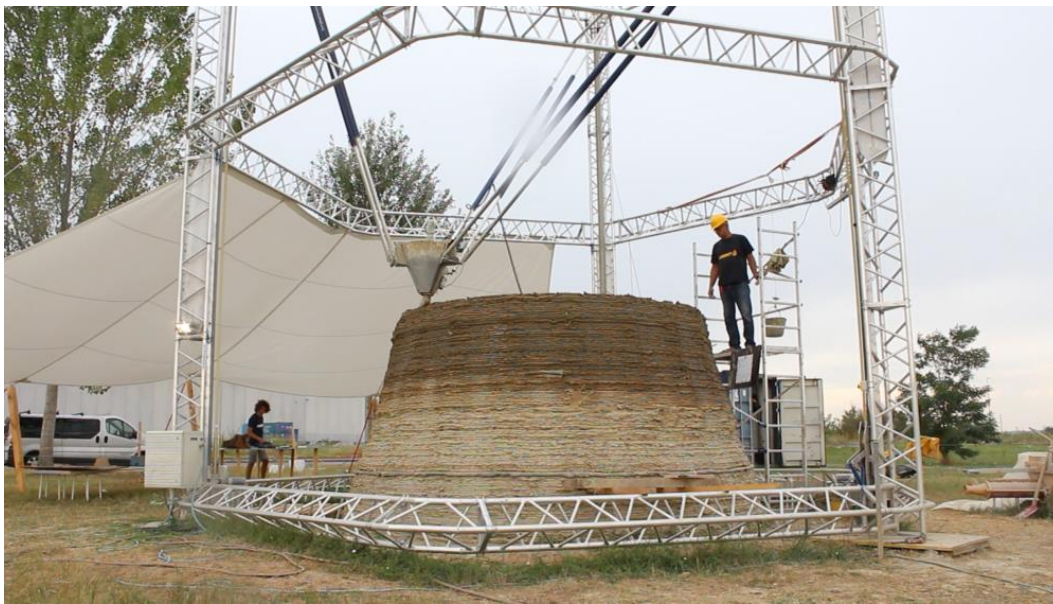
Figura 1.9. Produzione di una casa stampata in 3D tramite estrusione di materiale (Wasproject)
