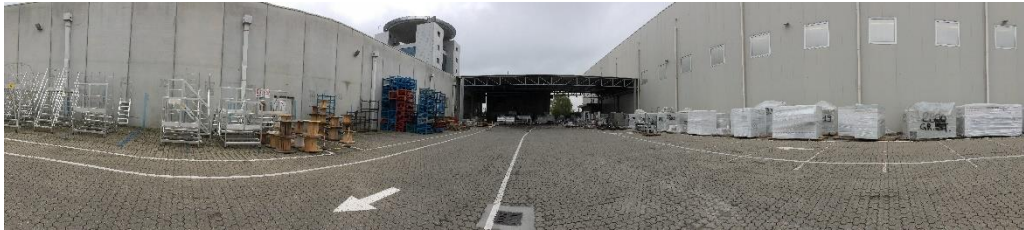
Figura 3.1.11: Zona dove entrano i camion e si effettua il ricevimento e lo scarico
