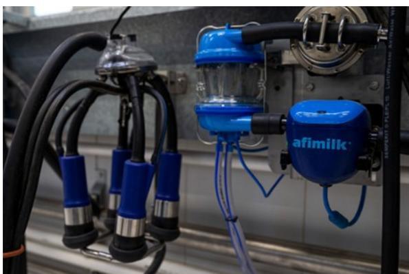
Figura 1: sensori Afilab e Afimilk MPC (Milk Point Controller) installati in una sala di mungitura. Foto da [www.lukrom.cz](http://www.lukrom.cz)
