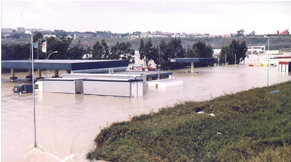
Figura 16 – Foto dell'esonazione del fiume Biferno nei pressi della zona industriale di Termoli (Fonte Relazione Generale del PP per le opere di messa in sicurezza del Biferno).
