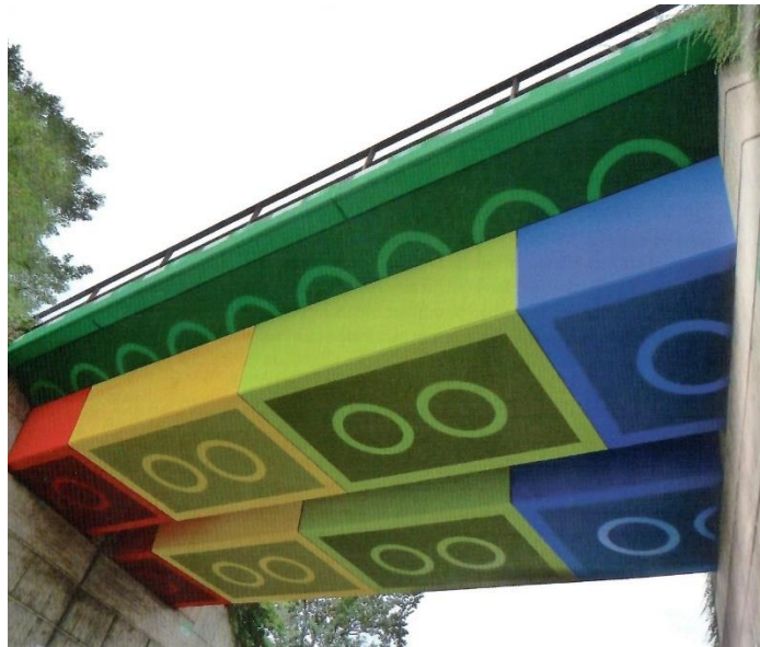
MegX, Ponte sulla linea ferroviaria , Wuppertal, 2011.
