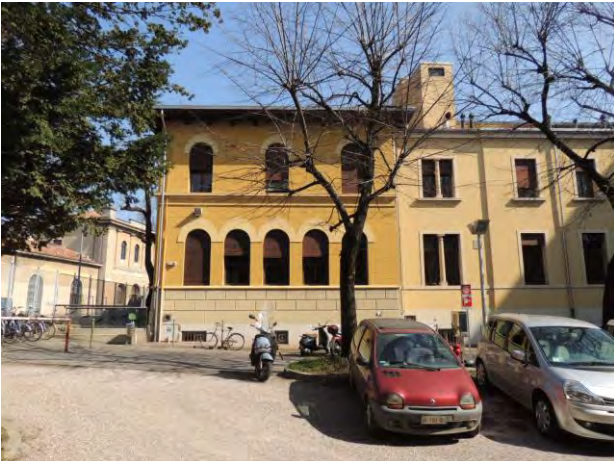
Figura 2.8: Prospetto ovest, fronte del corpo 1.
