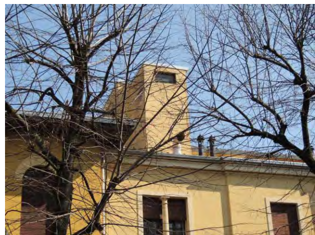
Figura 2.27: Copertura lignea del laboratorio, corpo 1
