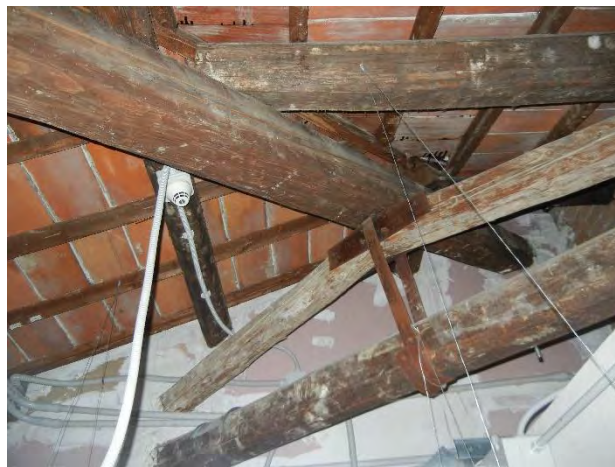
Figura 2.25: Copertura lignea del laboratorio, corpo 1.
