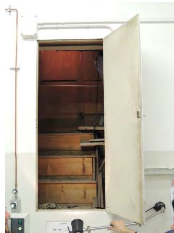
Figura 2.21: Accesso al sottotetto.
