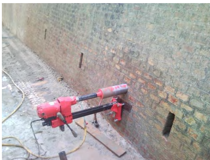
Figura 9.01: Prelievo di una carota di muratura.
