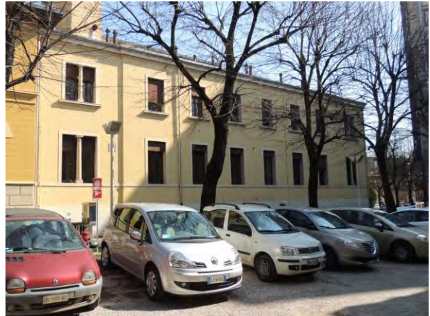
Figura 2.9: Prospetto ovest, fronte del corpo 1.
