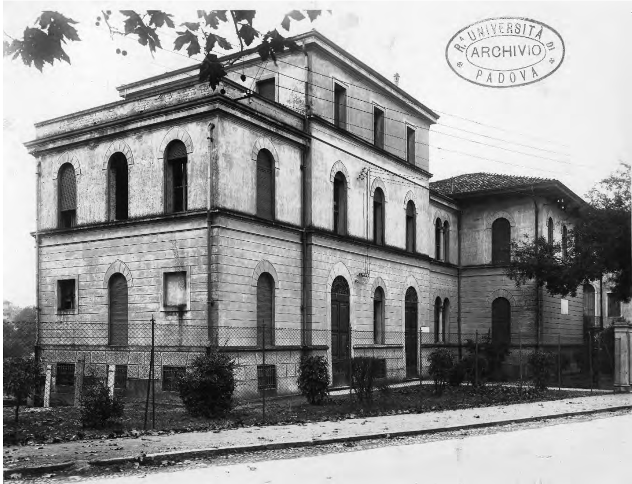
Figura 1.29: L'edificio di Farmacologia negli anni Venti, prima dell'ampliamento. Da notare l'assenza di aperture al pian terreno del corpo di fabbrica nell'angolo nord-ovest dovuto, secondo la ricostruzione, alla precedente sistemazione dell'aula come aula gradonata nonostante fossero previste nel progetto. Archivio Generale di Ateneo dell'Università di Padova, Fototeca dei Consorzi Edilizi.
