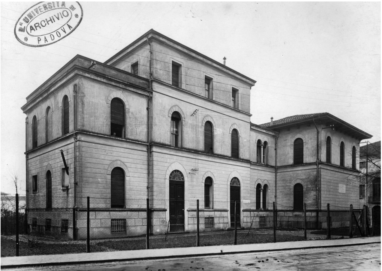
Figura 1.20: L'edificio di Farmacologia negli anni Venti, prima dell'ampliamento. Da notare l'iscrizione di intitolazione a Bonafede, sulla destra, e lo sfiato dell'impianto di termosifone a sinistra servente gli alloggi dei medici in formazione a Padova per il conflitto mondiale. Archivio Generale di Ateneo dell'Università di Padova, Fototeca dei Consorzi Edilizi.
