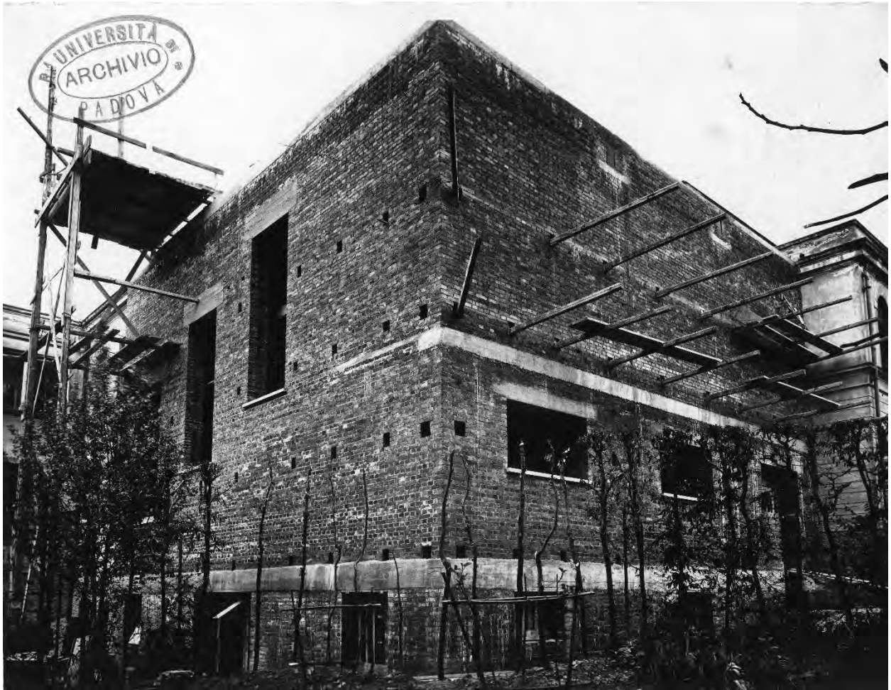
Figura 1.32: Aula gradonata in esecuzione prima dell'intonacatura. Archivio Generale di Ateneo dell'Università di Padova, Fototeca dei Consorzi Edilizi.
