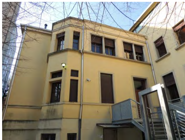
Figura 2.5: Prospetto est, fronte del corpo 1.
