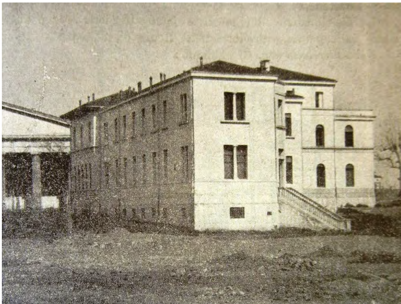
Figura 1.19: L'edificio appena costruito, visto da sud. Si nota la bella scalinata in pietra che si protendeva verso lo stabulario. In Luigi Sabbatani, L'Istituto di Farmacologia dell'Università di Padova , 1922. Sullo sfondo si nota l'Istituto d'arte Pietro Selvatico.
