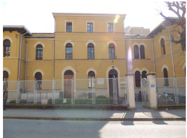
Figura 2.2: Prospetto nord, ingresso principale dell'edificio.
