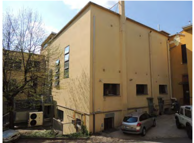
Figura 2.4: Prospetto est, fronte del corpo 2.
