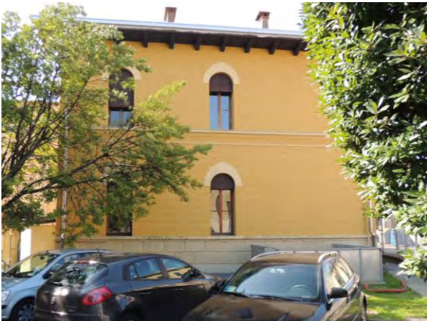
Figura 2.3: Prospetto est, fronte del corpo 3.
