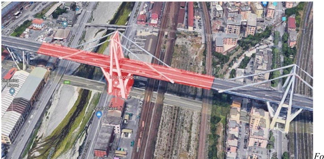
Fig. 3.4.1. Immagine della sezione e del pilone crollato
