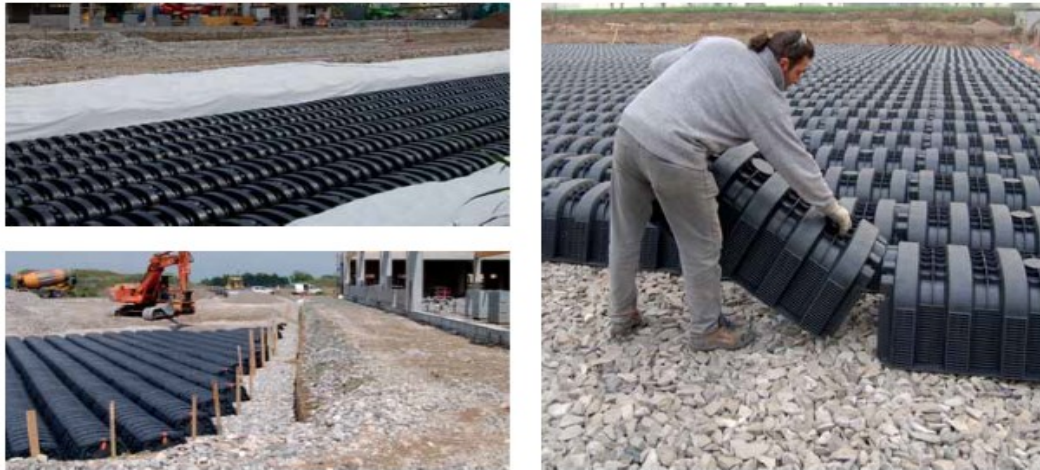
Figura 20: Esempio di sistema di accumulo interrato.
