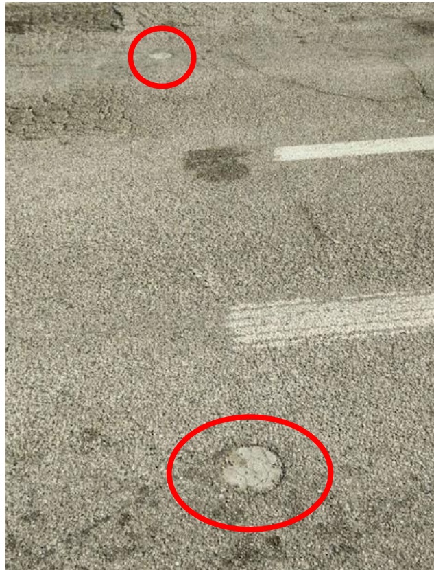
Figura 3.5 - Esempio di installazione dei sensori wireless in due corsie di accesso ai terminal.
