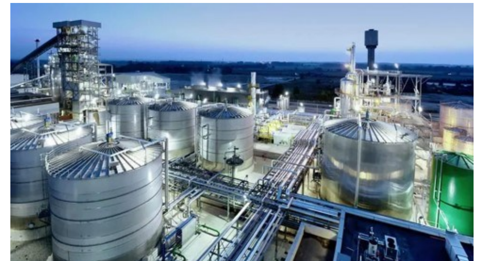
Impianto di produzione di bioetanolo da biomassa lignocellulosica a Crescentino (Vercelli)
