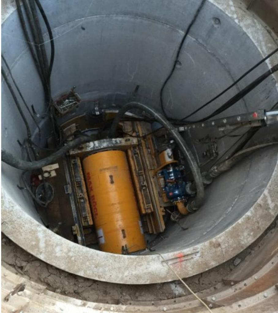
Figura 15: Esempio di cantiere di un pozzo di spinta.
