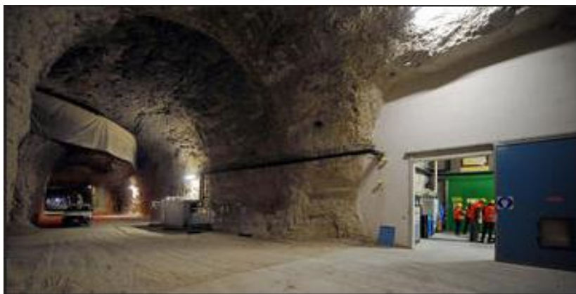
Fig. 4.2- Ingresso cella sperimentale
