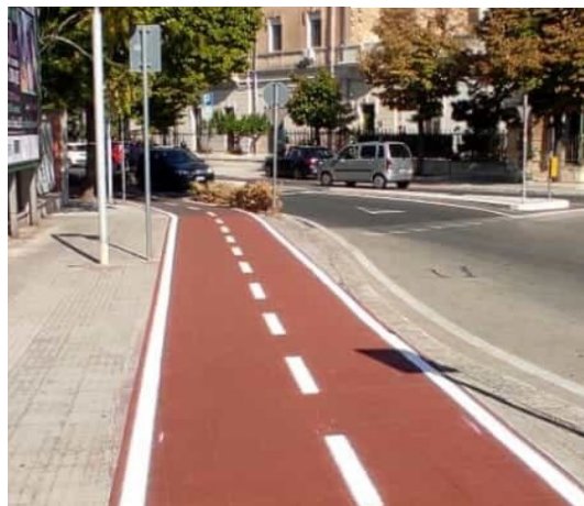
Figura 3: Pista ciclabile su marciapiede (fonte: comune.lecce.it).
