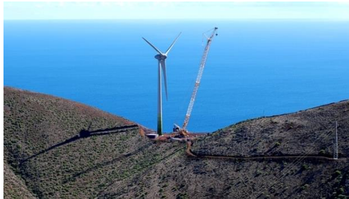
Fig 5.1 – Installazione di un aerogeneratore nell'isola di El Hierro
