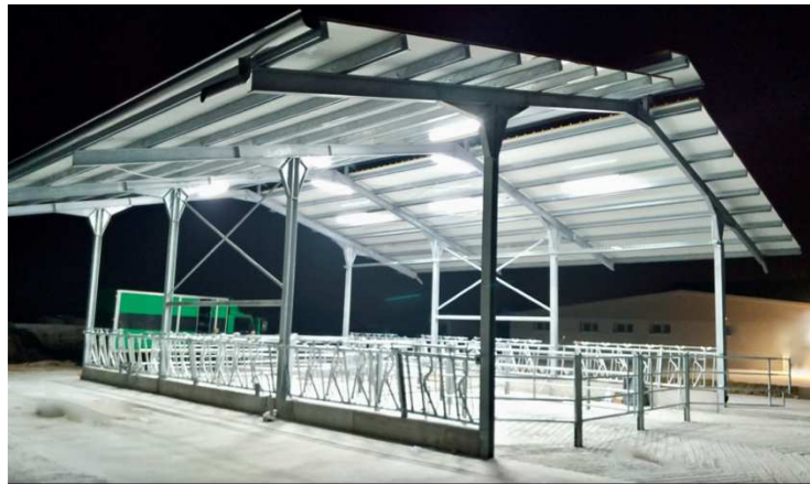
Foto 7: esempio di stalla senza pareti e con tetto a camino, in un allevamento intensivo a Padova, per gentile concessione del Dott. Alessio Colizzi
