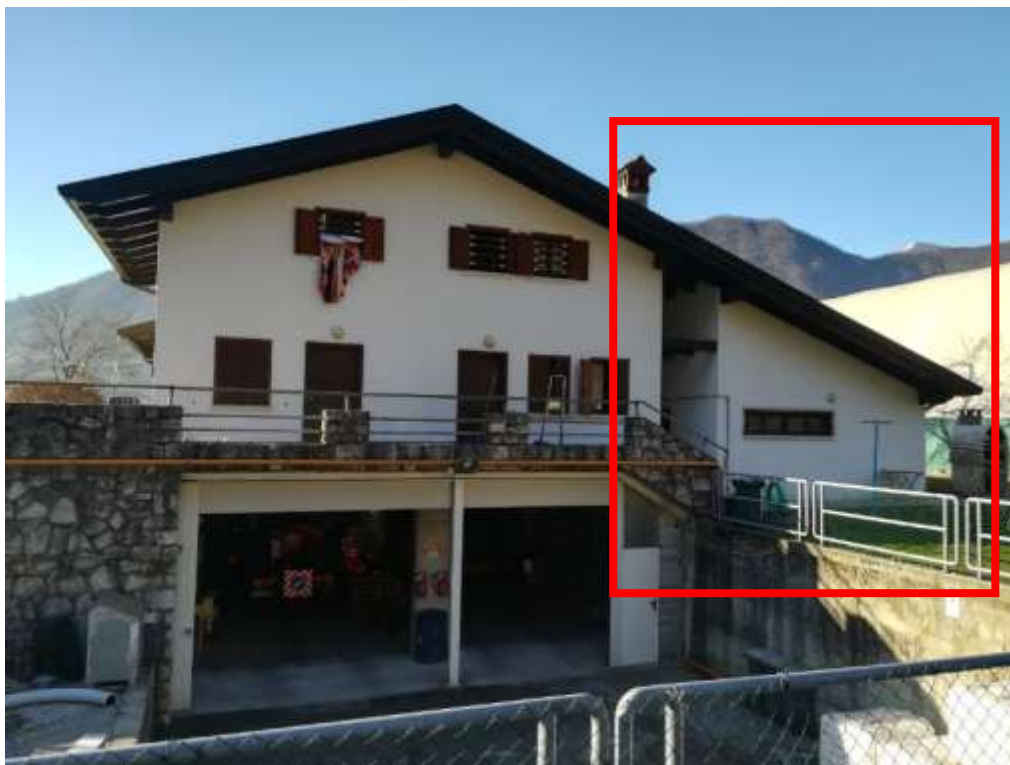
Fig. 2.5 blocco spogliatoi e alloggio del gestore sul versante est
