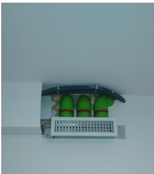
Figura 3.8 Dettaglio immissione aria zona notte.
