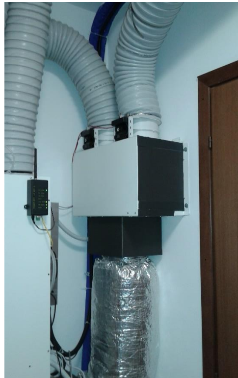
Figura 3.5 Box di distribuzione multizona (2 zone).
