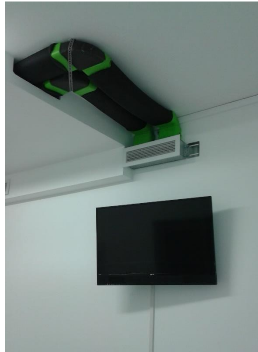
Figura 3.7 Dettaglio immissione aria zona giorno.
