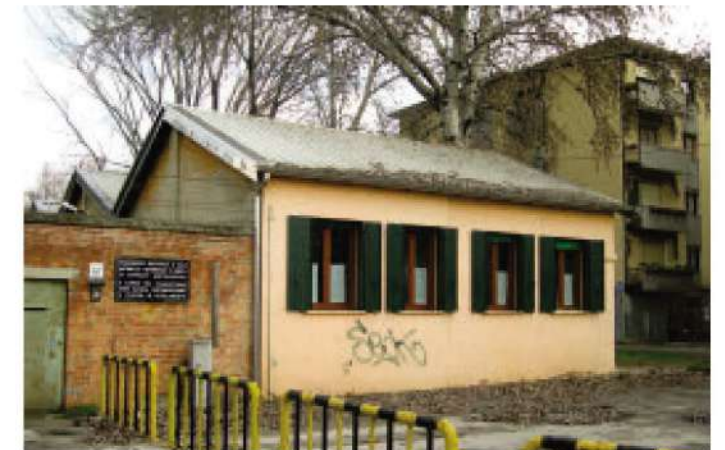
Vista esterno edificio Ex scalo merci
