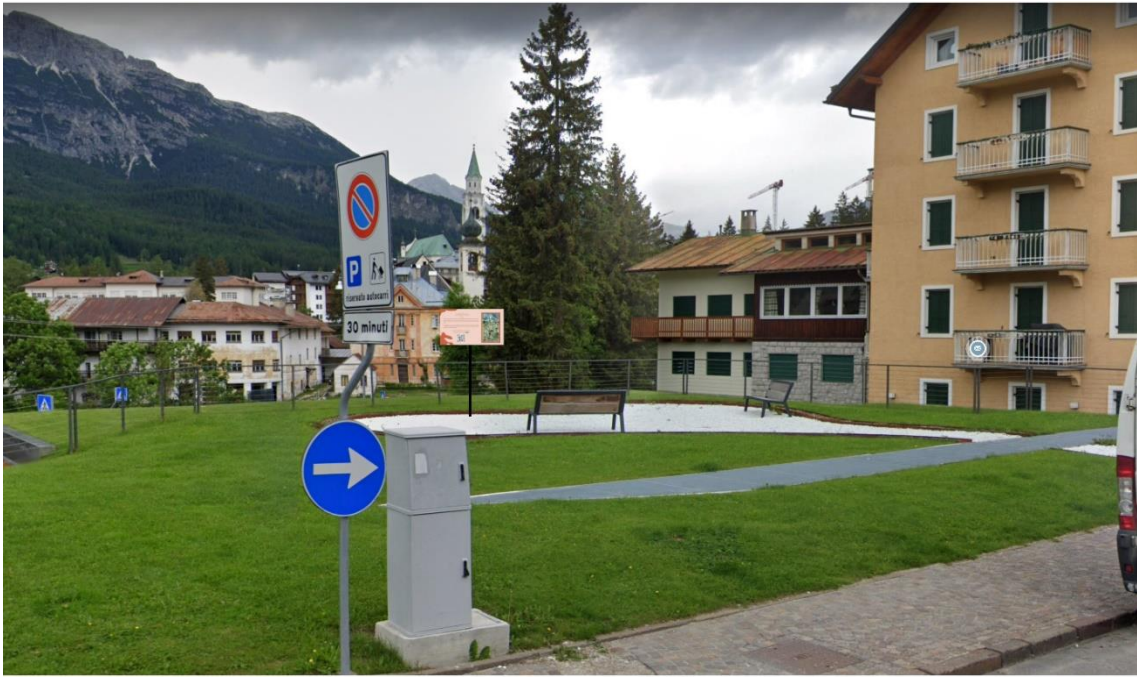
Fig. 52, Ipotesi di posizionamento del pannello Cortina in Via Roma, nei pressi dell'ex Garage Centrale.
