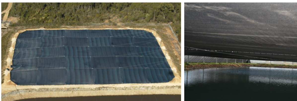
Fig. 5. Invaso coperto con rete ombreggiante in tensione (foto presa da East Gippsland Water, 2023)
