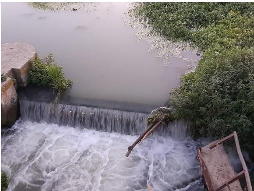
*Figura 32- sbarramento del manufatto di Buoro, differenza livello monte-valle*
